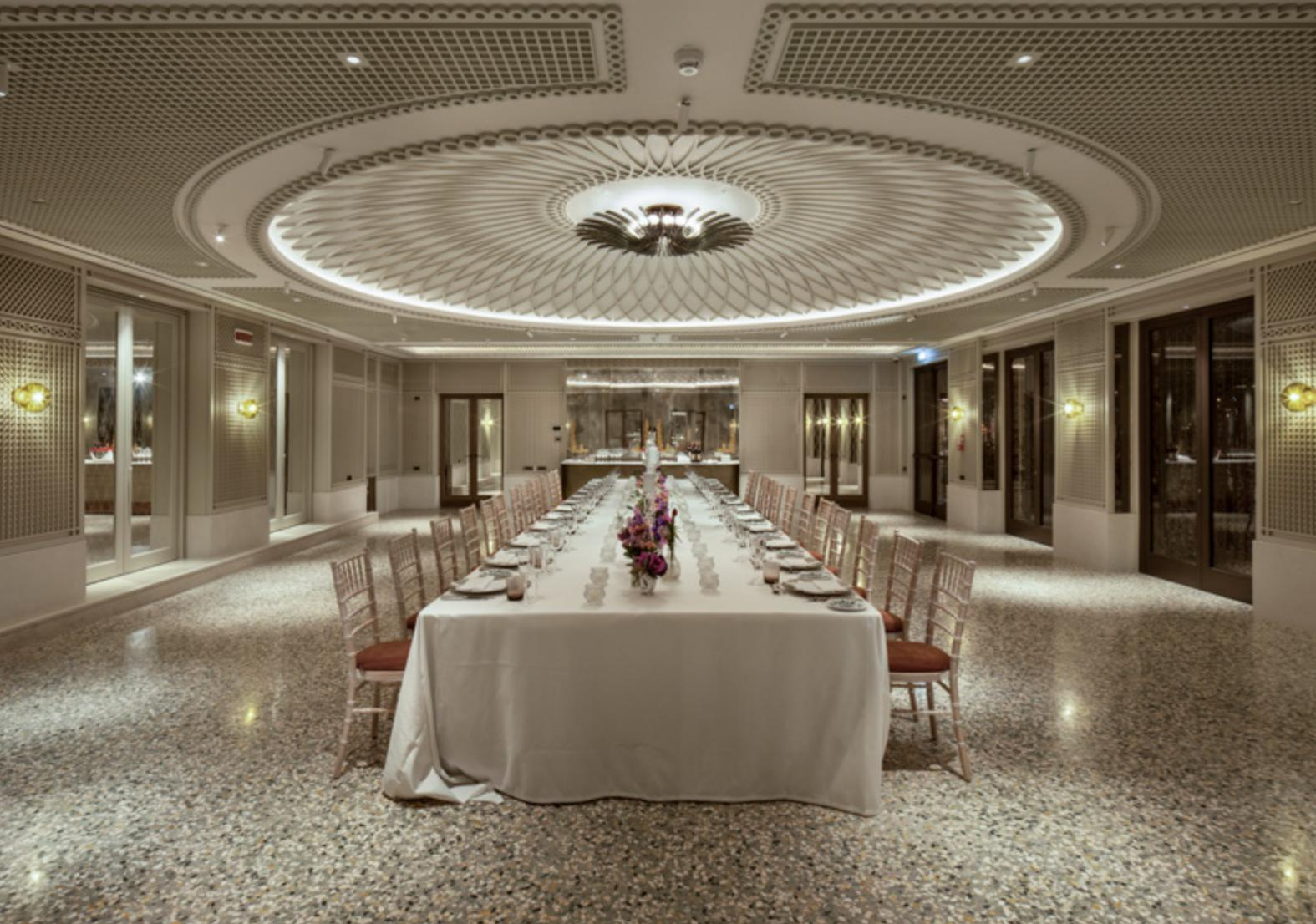
Nella sala Canaletto, del piano terra, sono stati realizzati a soffitto decori per superfici curve. Si è reso necessario un rilievo con laser scanner e ingegnerizzazione del modulo base per produrre lo spicchio di decoro perfetto
